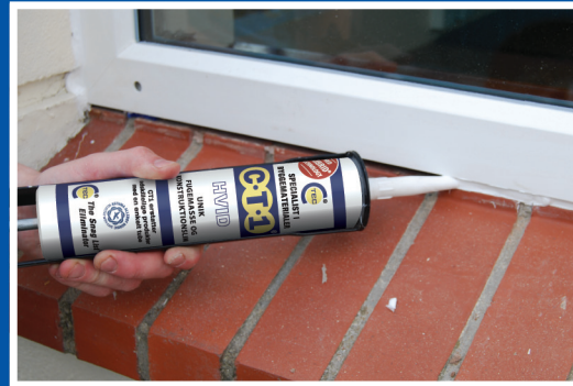
Hurtig tætning af fuger
