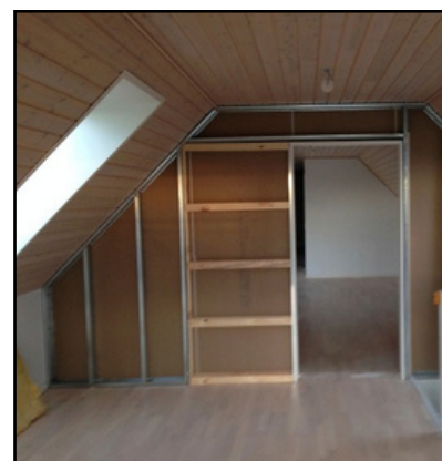
Karmen er klar til montering af gipsplader
