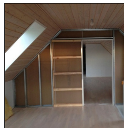
Karmen er klar til montering af gipsplader
